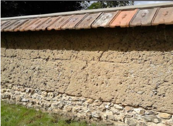
Mur en terre sur solin en Pierre avec couverture en tuile terre cuite.
