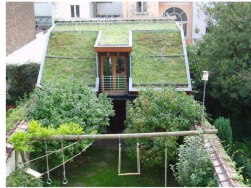
Toiture verte (Source : Inter-Environnement Bruxelles)
